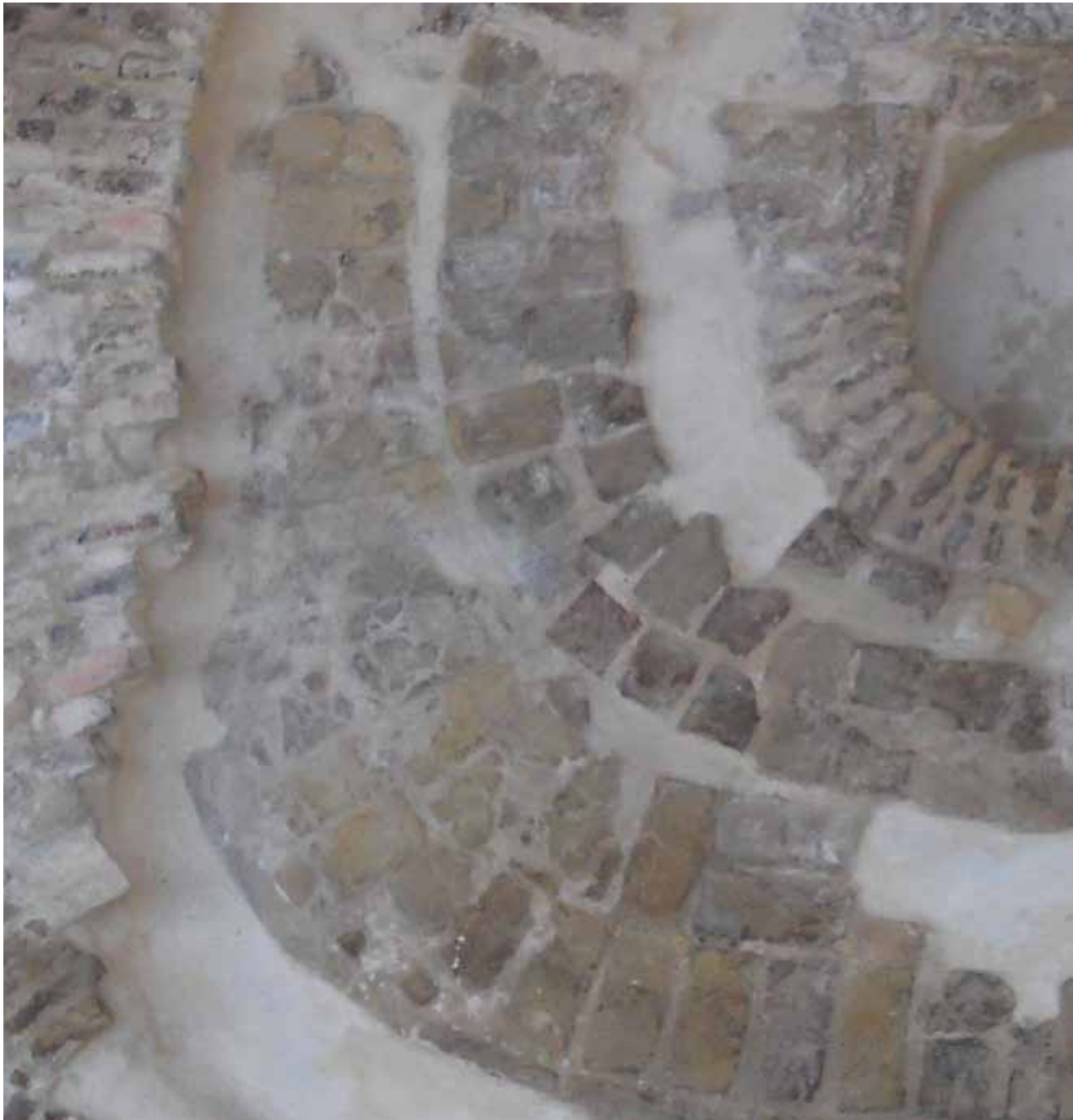
Detalle de la restauración de uno de los molinos
