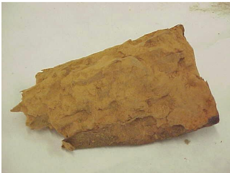
Fig. 2 – Madera anclaje: carcomida por insectos. Serrín compacto.
