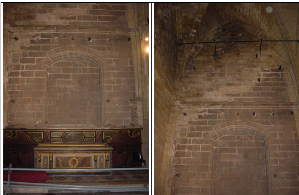
Vista del muro de apoyo trasero después del desmontaje del retablo.
