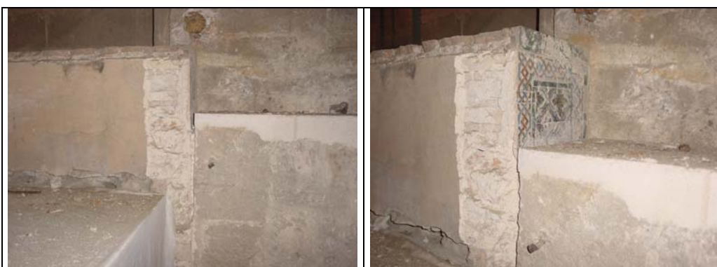
Vista de las fábricas de ladrillo y piedra del sotobanco.
