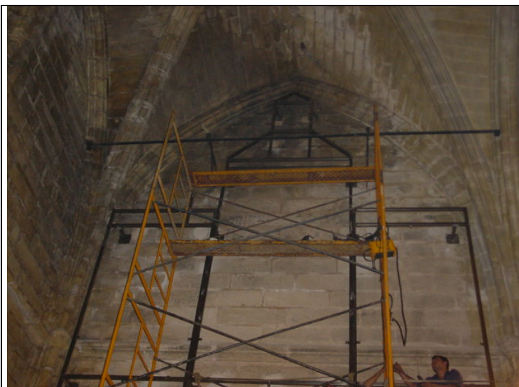
Montaje de la estructura portante
