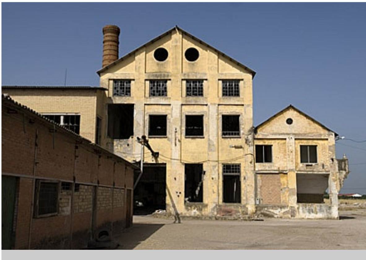
Azucarera San Fernando y Destilería Los Rosales. Sevilla
