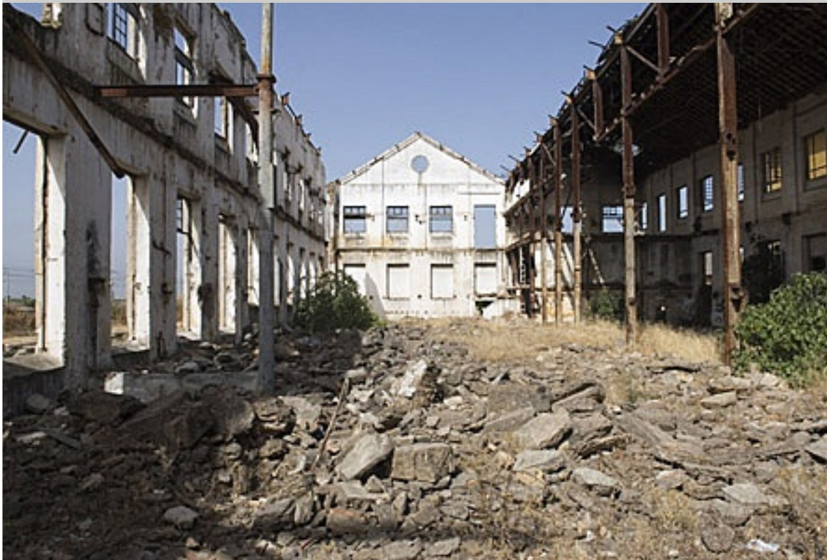
Azucarera San Fernando y Destilería Los Rosales. Sevilla
