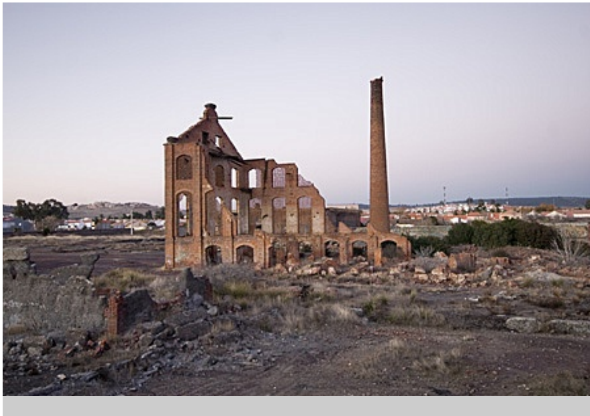
Cerco Peñarroya-Pueblonuevo, Córdoba
