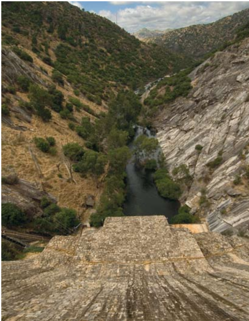
Presa y central hidroeléctrica del Jándula (1927). Foto: Juan Carlos Cazalla, IAPH
