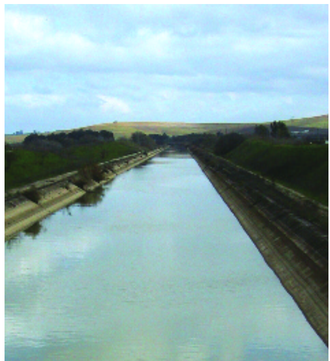
Canal del Bajo Guadalquivir. Foto: Manuel Calzada
