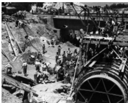
Obras del canal, sifón de El Coper, en las proximidades de Los Merinales
