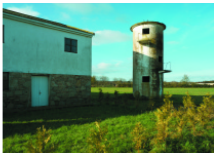
Silo en Espiñeira
