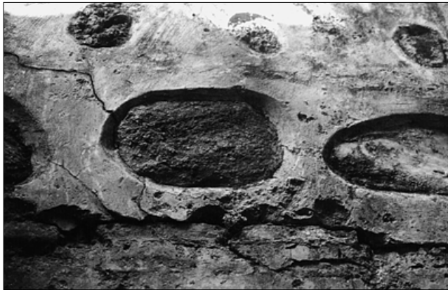
6. Detalle de una construcción en mampostería organizada con ripios
