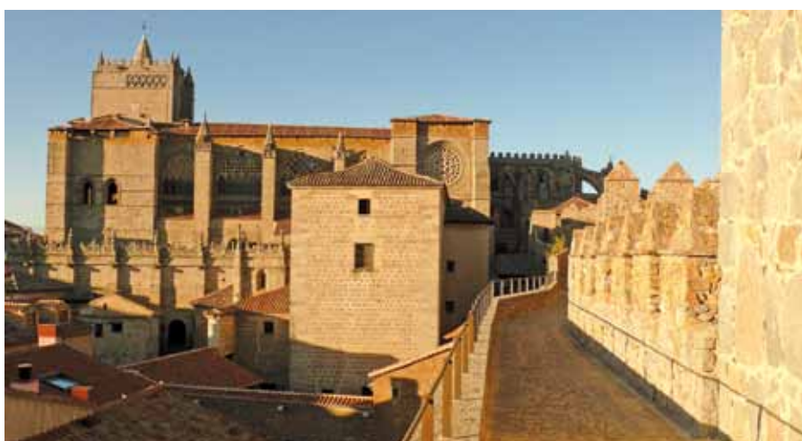
Paseo de la muralla de Ávila, actuación concreta para potenciar la accesibilidad. Foto: Joan Grífols
