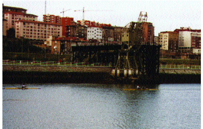
Foto 3: El mismo cargadero Restaurado el año 2002 por Bilbao-Ría 2000
