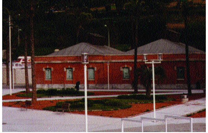
Foto 1: Casa de motobombas en Elorrieta, futura sede de un “Museo del agua”
