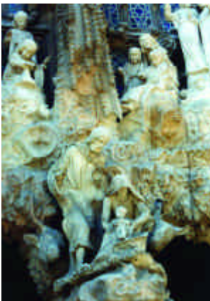
Detalle de la Fachada de la Natividad del Templo de la Sagrada Familia de Gaudí. Barcelona
