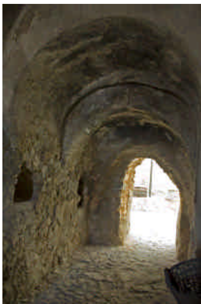
📍 Cavidad de acceso a un horno de cal (Morón de la Frontera, Sevilla) / JAVIER ROMERO, IAPH
