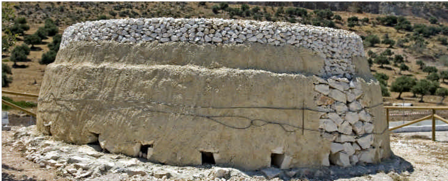
◆ Colmo de un horno en proceso de construcción (Morón de la Frontera, Sevilla) / JAVIER ROMERO, IAPH
