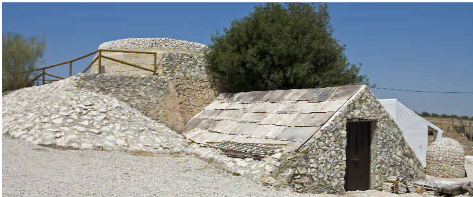
◆ Horno de cal rehabilitado (Morón de la Frontera, Sevilla) / JAVIER ROMERO, IAPH
