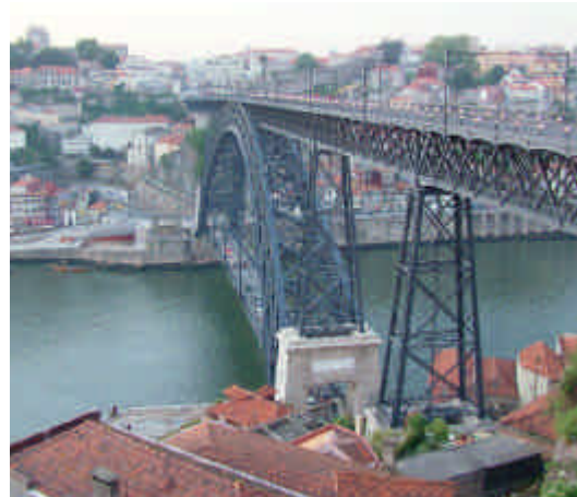
W Puente Don Luís I, construido en 1886 por discípulos de Gustave Eiffel; sus dos tramos comunican los barrios alto y bajo de la ciudad de Oporto / ISABEL DUGO
