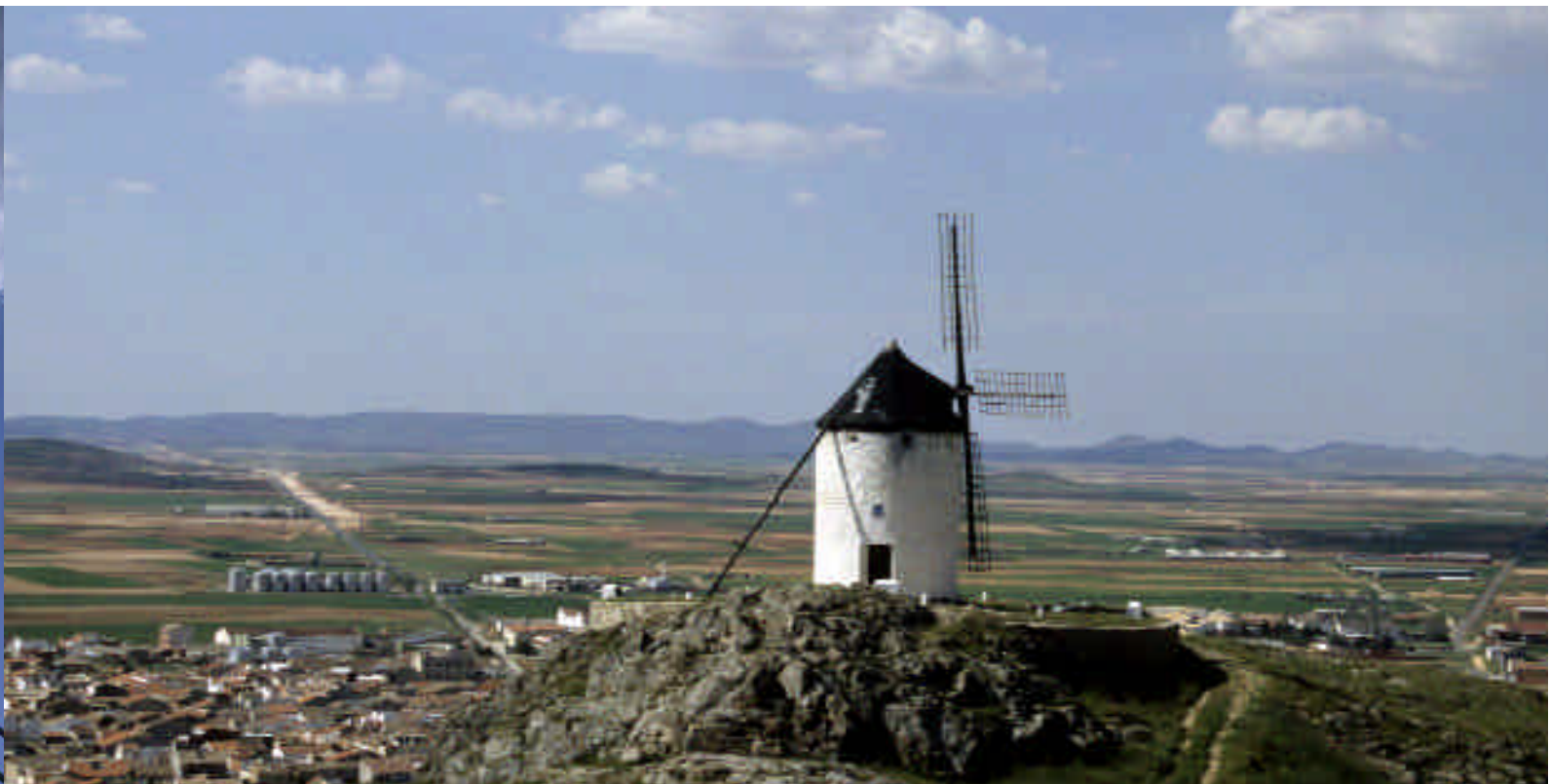
W Algunos de los molinos rehabilitados de Consuegra han sido rebautizados con nombres cervantinos: Mambrino, Rucio, Clavileño, Cardeño, Sancho... / ISABEL DUGO
