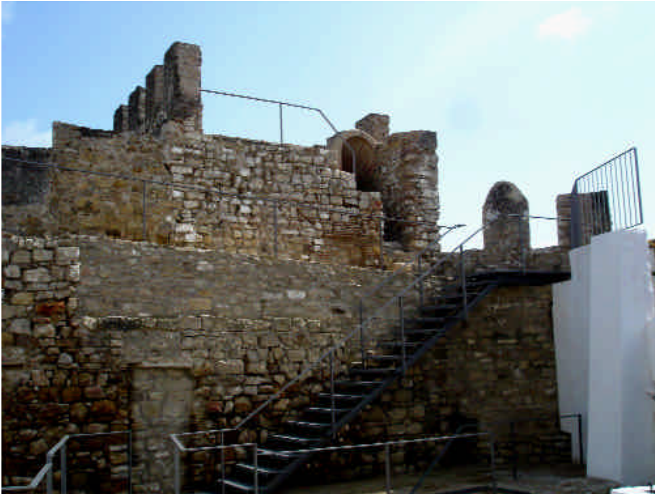
W Intervención. Vista de la torre desde la plaza del aljibe. Restitución del paso de ronda y accesos al cuerpo de guardia / FRANCISCO REINA
