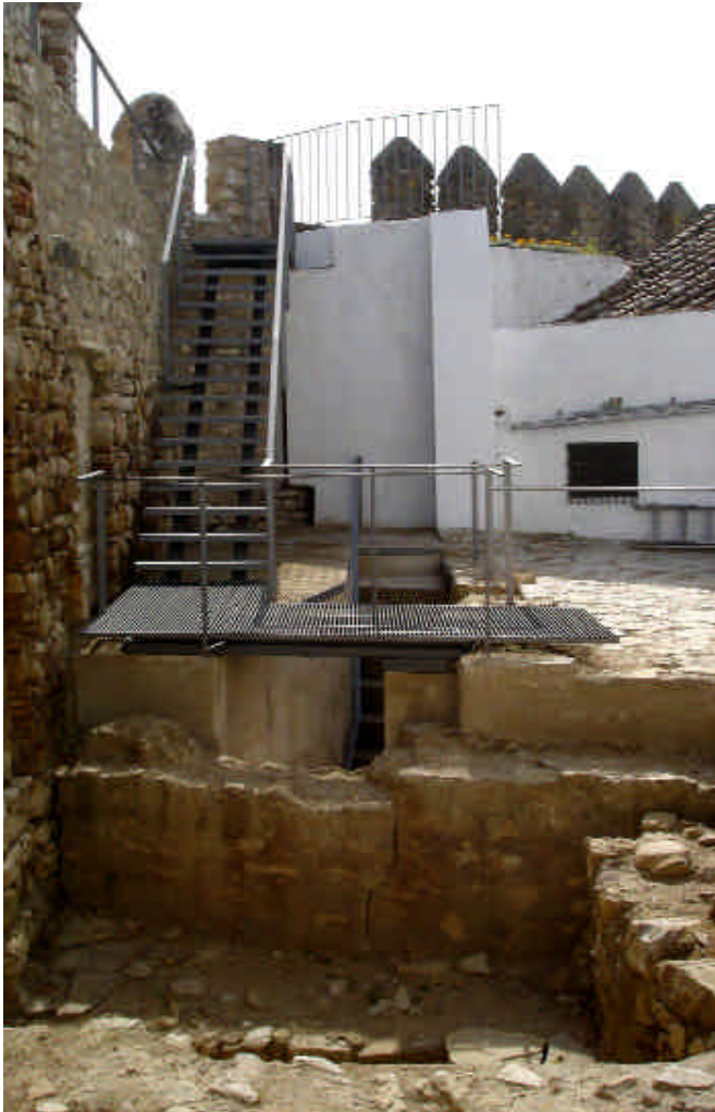
W Detalle de las pasarelas y protecciones de huecos en los pozos del aljibe / FRANCISCO REINA
