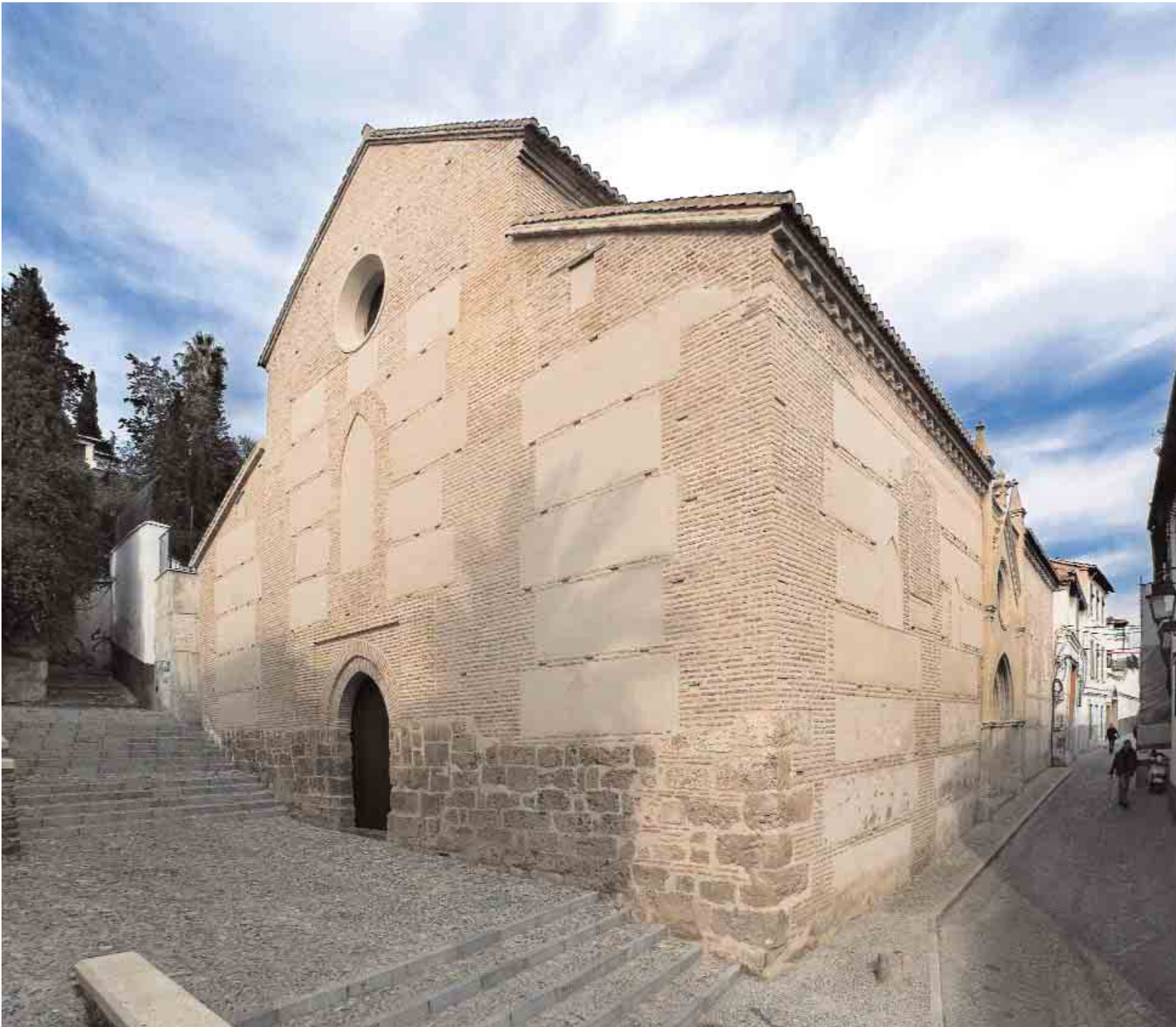
© La iglesia San Juan de los Reyes después de la restauración / JAVIER ALGARRA
