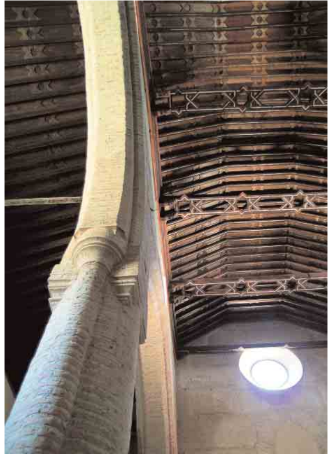
➤ Detalle del arco y pilastra de ladrillo / JOSÉ MANUEL LÓPEZ OSORIO
