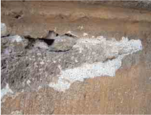
④ Detalle de la Fachada Norte donde se observa la sucesión de revestimientos / MARTA GARCÍA DE CASASOLA, IAPH
