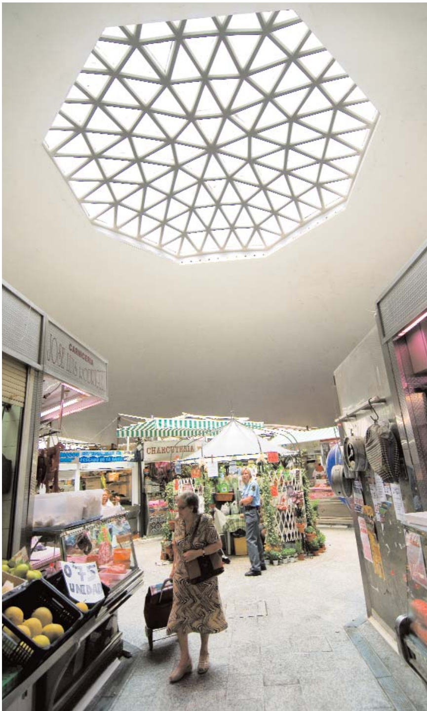
📍 Mercado de Abastos de Algeciras (Cádiz), diseñado en 1936 por Eduardo Torroja Miret y Manuel Sánchez Arcas / JUAN CARLOS CAZALLA, IAPH
