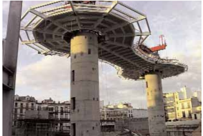
📍 Metropol Parasol. Plaza de la Encarnación en Sevilla. J. Mayer H., Arquitecto. 2005 / JAVIER SÁNCHEZ-MATAMOROS PÉREZ
