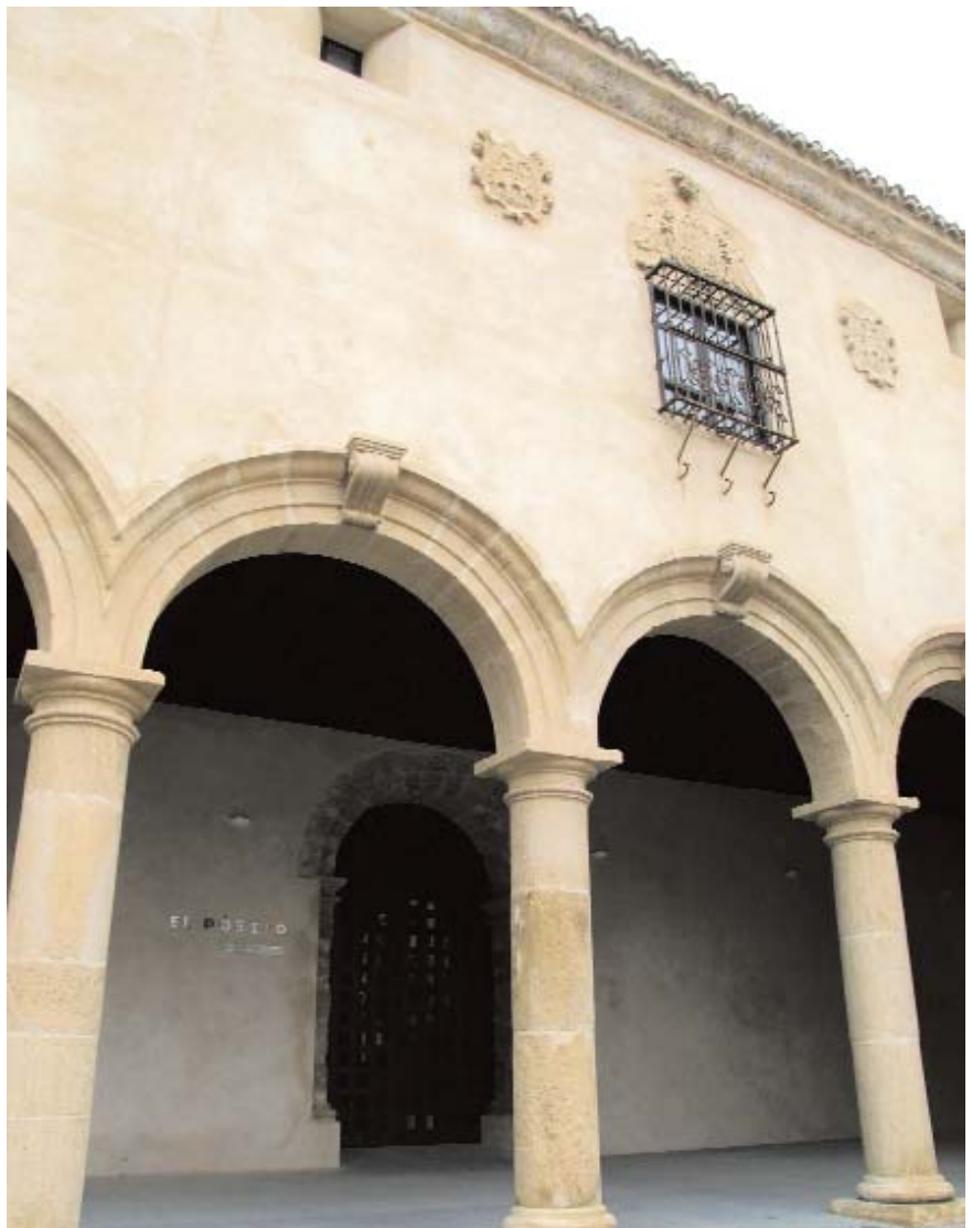
↓ CIC El Pósito de Loja (Acceso a sala de exposiciones) / FUENTE: ÁREA DE CULTURA DEL AYUNTAMIENTO DE LOJA
