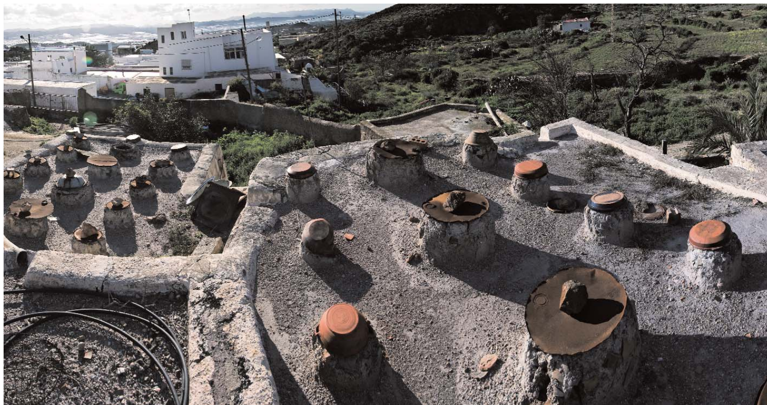
📍 Hornos morunos. Vista panorámica de la zona de cubierta salpicada de brameras, utilizadas para regular el proceso de cocción. Alfarería Hermanos Góngora en Níjar / FOTO: JUAN CARLOS CAZALLA, IAPH
