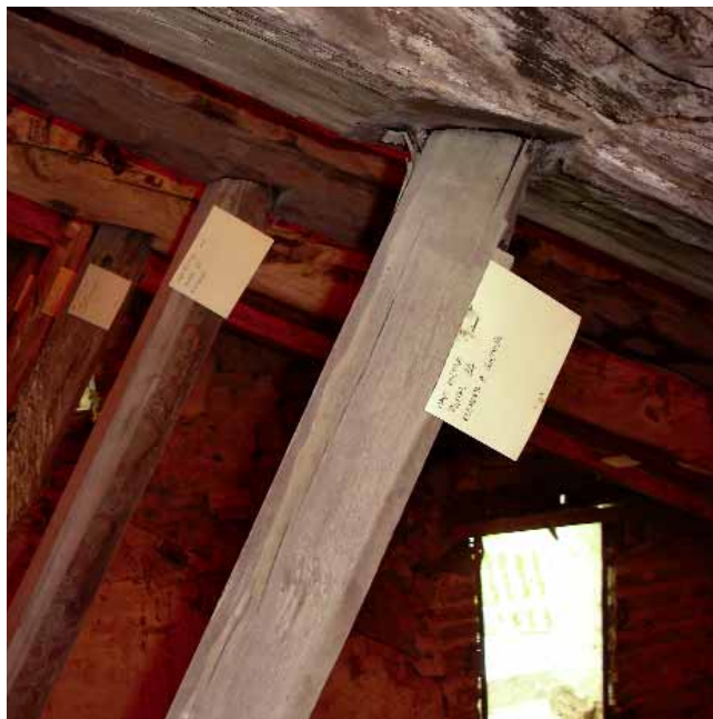
⌚ Datación de elementos de la cubierta previo a su reparación o sustitución / FOTO: VALENTÍN TRILLO
