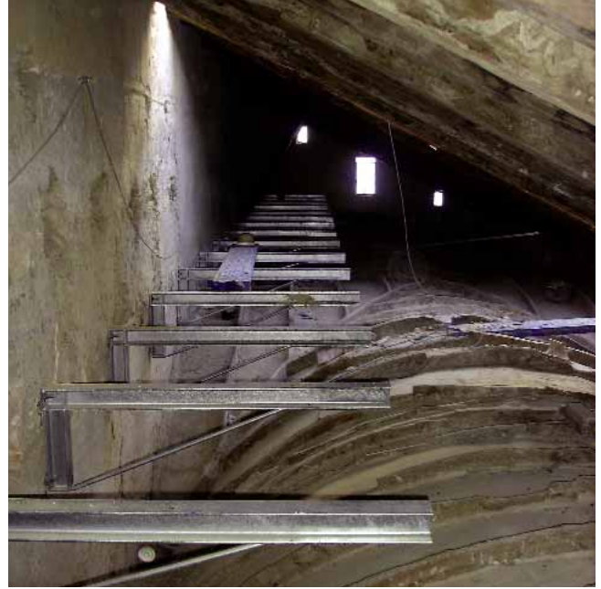
Colocación de ménsulas metálicas en nave lateral / FOTO: VALENTÍN TRILLO
