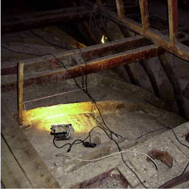
Replanteo de estructura metálica en nave central / FOTO: VALENTÍN TRILLO
