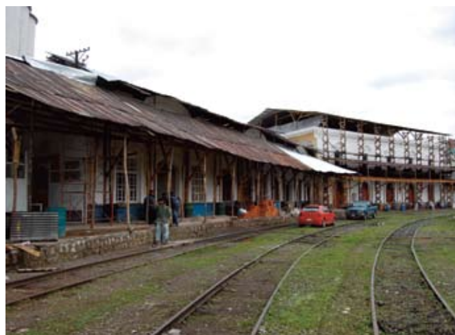
Rehabilitación de la Estación de Chimbacalle. Foto: Erik Olsson
