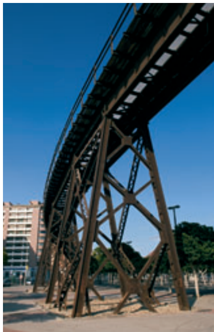
Cargadero de mineral El Alquife. Almería. Foto: Juan Carlos Cazalla, IAPH
