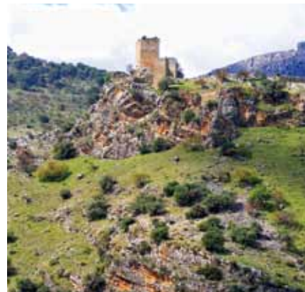
Castillo de Otiñar, en la Sierra Sur jiennense. Foto: Abraham López Moreno
