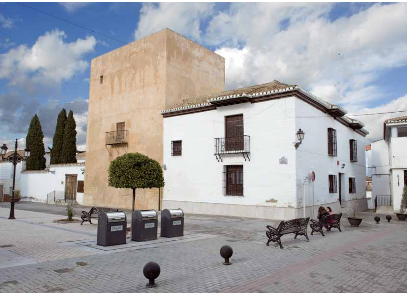
El fuerte de Gabia. Foto: Juan Carlos Cazalla, IAPH
