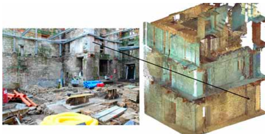
Documentación geométrica mediante láser escáner terrestre de un edificio del casco antiguo de Santiago de Compostela (Rúa do Preguntoiro, 23). A la izquierda de la imagen, estado del edificio justo antes de su destrucción. A la derecha, resultado obtenido tras la documentación tridimensional de una parte del mismo (la flecha indica, en ambas imágenes, la posición de referencia para la toma de datos). Fuente: CSIC
