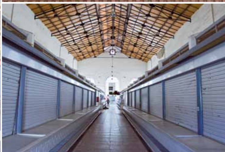
Detalle de la fachada y vista interior del mercado de abastos de Linares.
