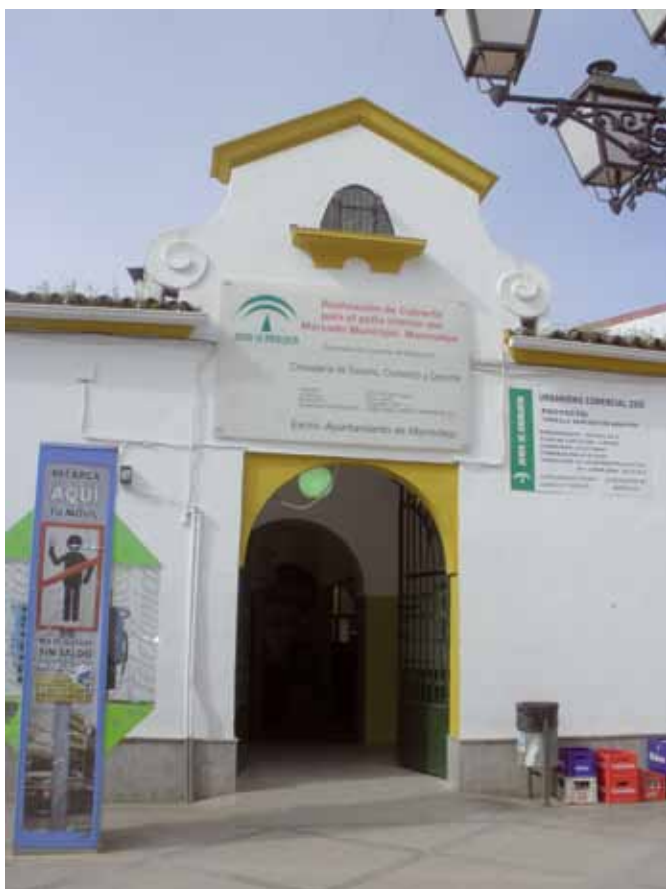
Fachada principal del mercado de abastos San José en Marmolejo. Fuente: Fondo Gráfico IAPH
