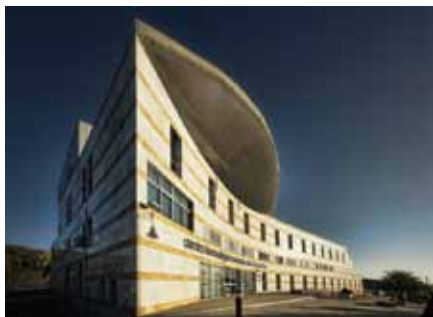
Centro Tecnológico Andaluz de la Piedra. Foto: Ctap
