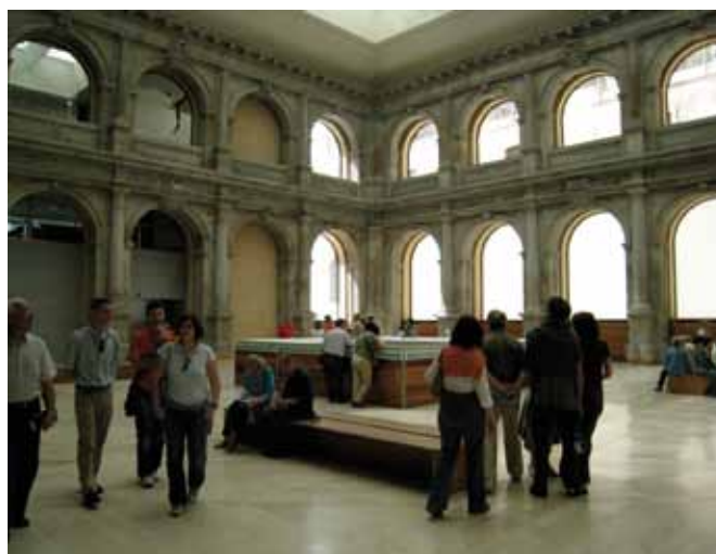
El claustro contiguo al templo parroquial de San Jerónimo el Real se encontraba en una situación de deterioro o degradación visible. La actuación consistió en desmontar la arquería en que consiste hoy el bien de interés cultural, restaurarla y reponerla en una composición idéntica a la que presentaba antes de su desmontaje dentro de un nuevo edificio en forma de cubo destinado a museo. Foto: Fernando García
