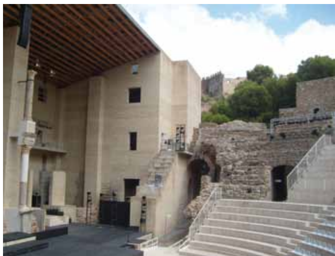
En 2009, en respuesta a la solicitud del gobierno valenciano, el TS confirmó la imposibilidad de ejecutar la sentencia que condenaba a la demolición de las obras del teatro de Sagunto, ya que podría ser demolido y al día siguiente, como consecuencia del cambio legislativo, levantarse exactamente igual sin que fuese contrario a Derecho. Fotos: Sergio Geijo
