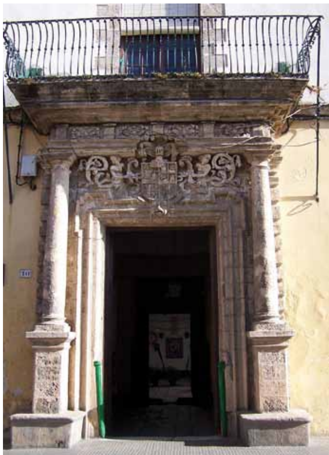
La entidad promotora que demolió el interior de la casa de las Cadenas de El Puerto de Santa María (Cádiz) se escudó en la autorización del Ayuntamiento a pesar de obviar las diligencias previstas en la legislación autonómica. Foto: Paco González (gonza)
