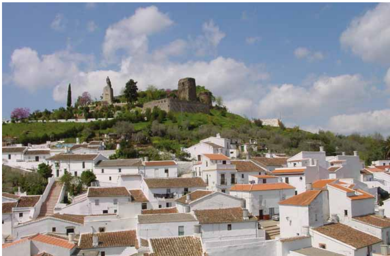
La torre del homenaje del castillo de Constantina (Sevilla) se desplomó en marzo de 2010, un caso en el que entran en conflicto el ente titular del bien y la autoridad competente para su protección. Foto: imagen cedida por Ana Avila
