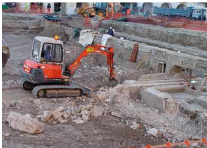
La excavadora trabaja sobre los restos de "El Salón" de Écija, Sevilla (7/2/2005). Fuente: Periódico ABC
