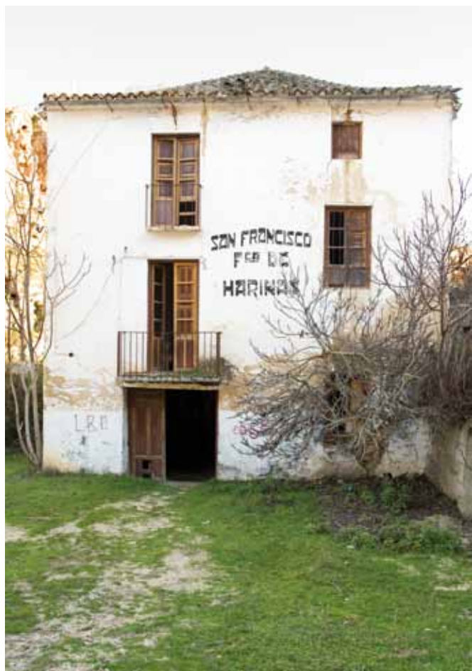
Fachada del molino de San Francisco en Alhama de Granada
