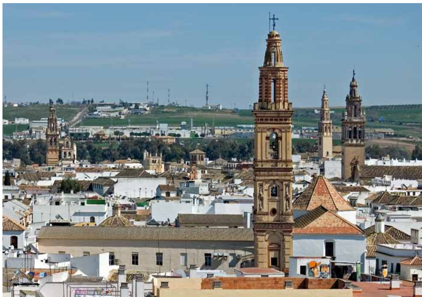
La sentencia del Tribunal Supremo en 2003 resuelve el derecho indemnizatorio del constructor de varias viviendas en Écija (Sevilla) tras la aparición de los restos del anfiteatro. Foto: Fondo Gráfico IAPH (Javier Romero García)
