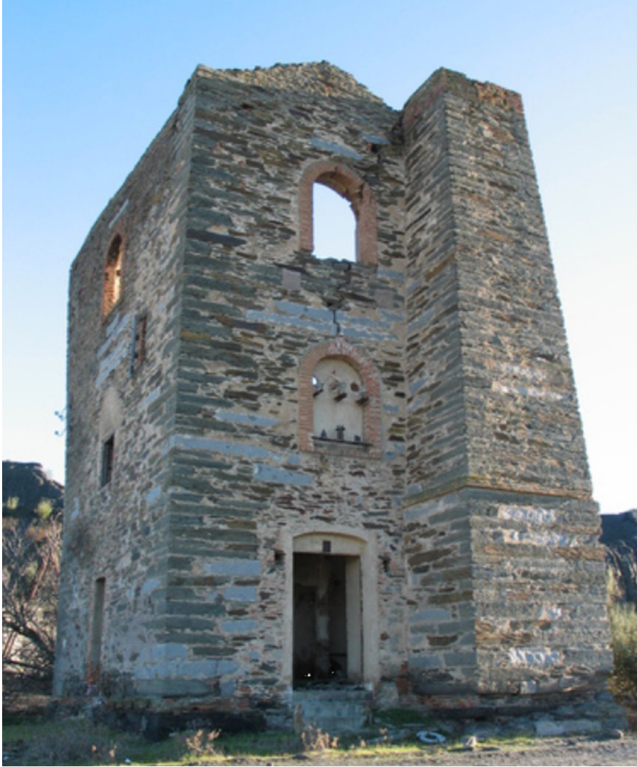
Casa de Máquinas de Mina Terreras
