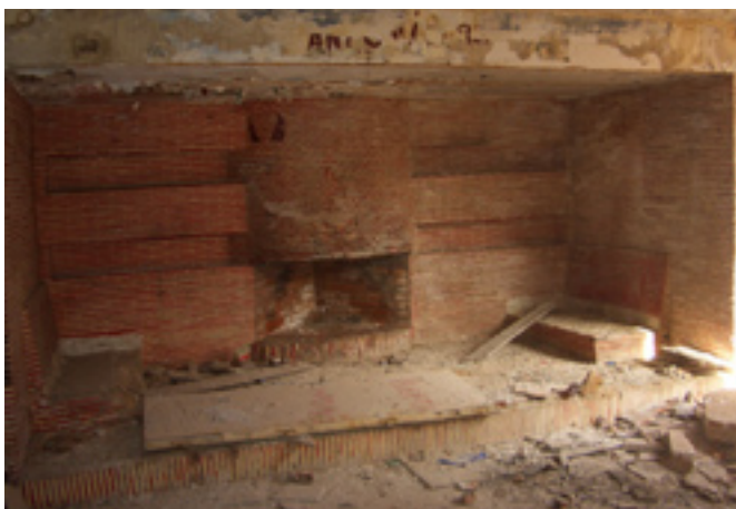
Zona de la chimenea del albergue de carretera en Bailén (2014) | foto autores
