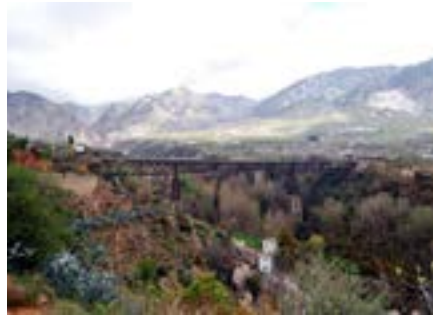
El puente de Lata sobre el río Dúrcal. Al fondo, Los Alayos y sierra de El Zahor
