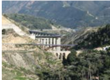
Acumulación de puentes y viales volados en la cerrada del río Izbor junto al núcleo de Acebuches
