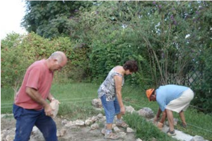
Voluntarios iniciando la construcción de la choza
