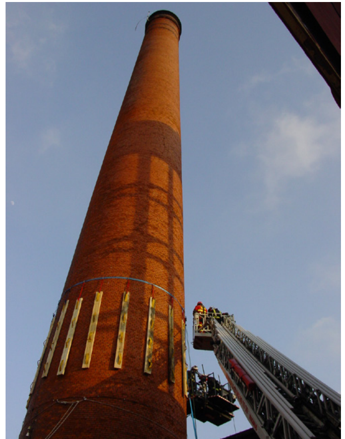
Simulacro de actuación: estabilización de patrimonio industrial. Ejercicio Emergencia de Interés Nacional “Cantabria 2017”. Participación conjunta de los equipos USAR de la UME, unidades de emergencia en patrimonio cultural (MEC y JCYL) y bomberos de España | foto UGRECYL
