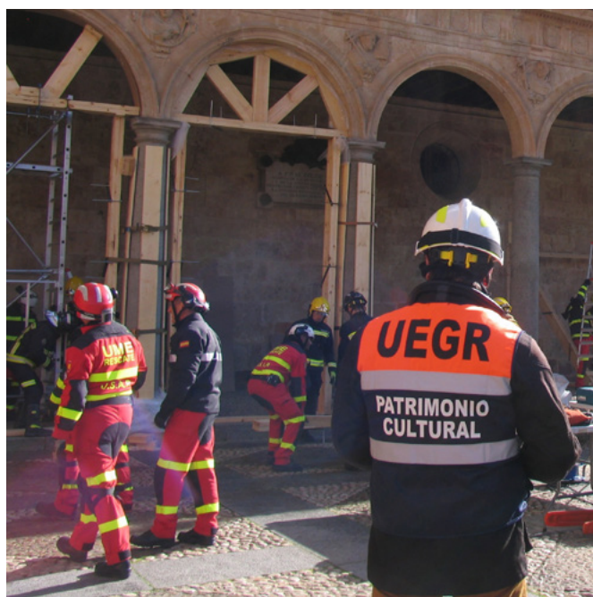
Ejercicio práctico de apeo de arcos. I curso de intervención en patrimonio cultural en situaciones de emergencia | foto UGRECYL
