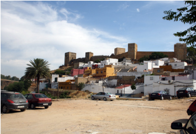
Barrio del Castillo de Alcalá de Guadaíra (Sevilla)
