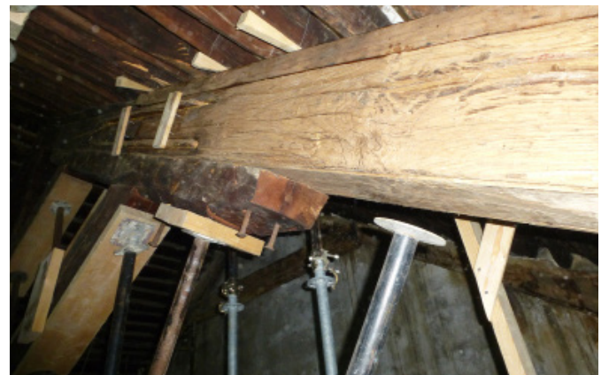
Más allá del edificio en toda su integridad, sus elementos estructurales tienen un valor propio a preservar. Restauración de la estructura de la cubierta de la Iglesia de la Natividad, Belén (Palestina)
