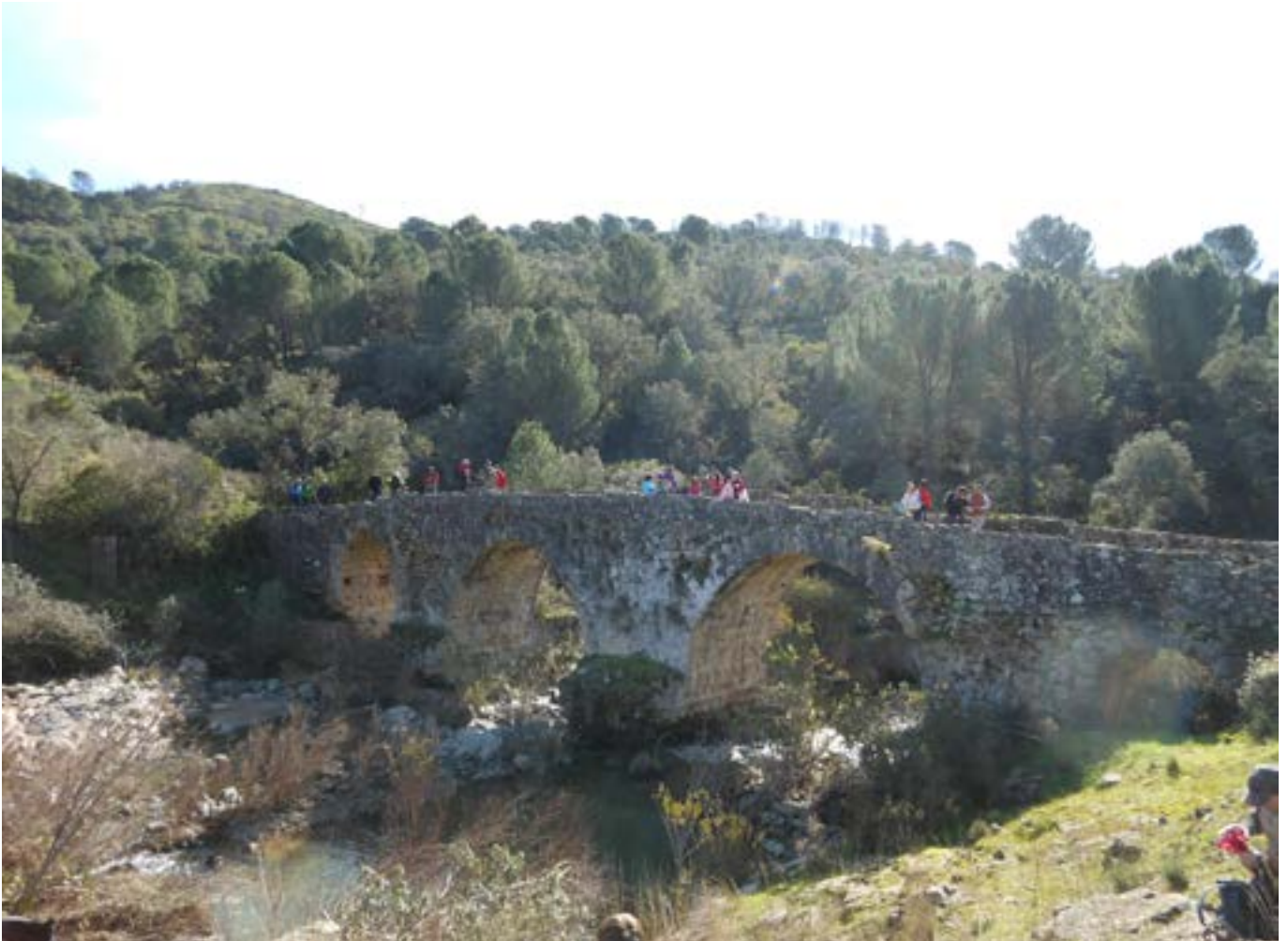
Puente de origen romano en la vereda del Pretorio (Córdoba) | foto Plataforma A Desalambrar
