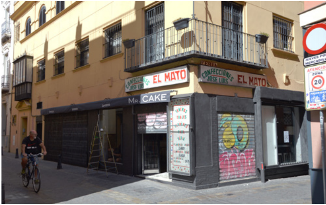
Transformación del tejido comercial en la calle Feria
