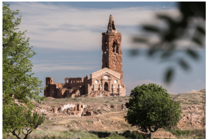
La iglesia de San Martín de Tours entre las ruinas de Belchite Viejo (Zaragoza) | foto Txetxu Rubio
