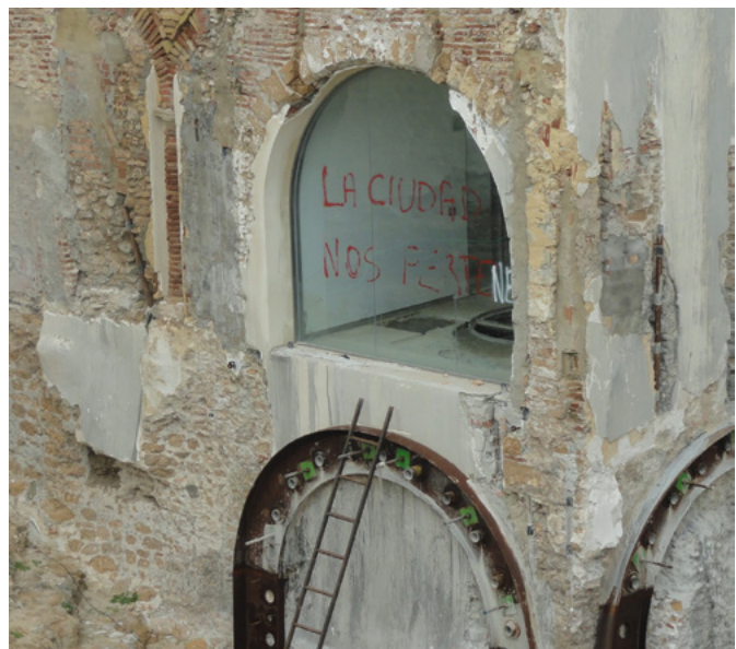
"La ciudad nos pertenece", pintada en el centro de interpretación del teatro romano de Cádiz, durante su rehabilitación (2017) | fotos M. a Carmen Reimóndez
