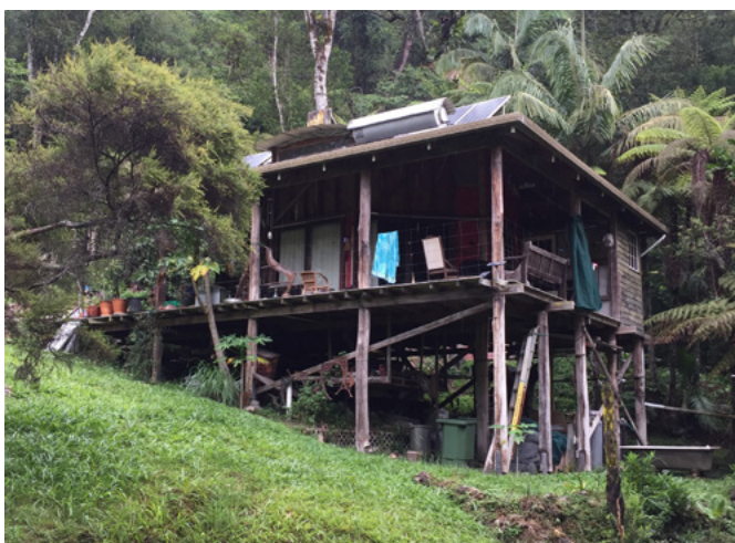
Nimbin, adaptación respetuosa con el entorno natural (superior); autoconstrucción autosuficiente (debajo) | fotos David Pascual
