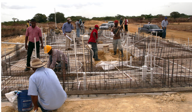
Inicio de la construcción de viviendas modelo en Ciudad Juan Bosch (República Dominicana) en 2015. El proyecto, iniciado en 2017, pretendía la construcción de 10.000 viviendas. Hoy aun no se ha concluido | foto Luis Burdies
