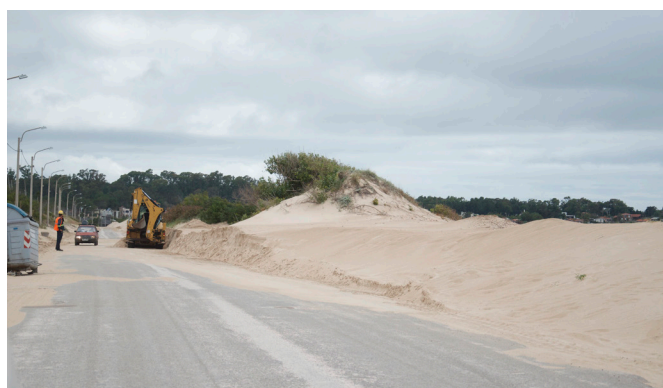
Retiro de arena con maquinaria pesada en rambla, año 2019 | fuente Proyecto ARCOS, oeste departamento Maldonado
