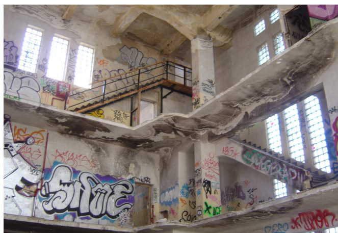
Estructura de acceso a los pisos de las galerías de la cárcel, noviembre 2007 | fotos Víctor Fernández
