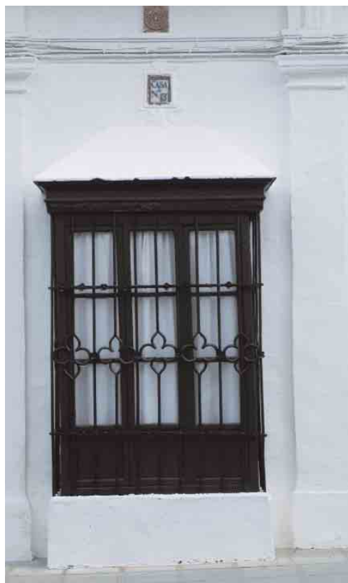
④ Detalle de ventana en calle San Pedro, Osuna (Sevilla) / ISABEL DUGO, IAPH
