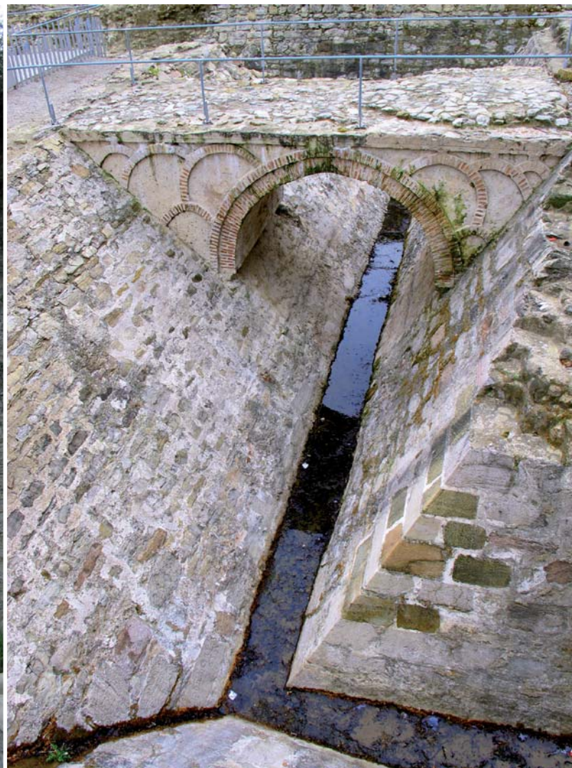
Foso con puente de acceso a la puerta de Gibraltar en la villa norte medieval de Algeciras. El foso rodea la puerta de Gibraltar formando una bifurcación en ángulo recto. El paso a la puerta se realizó mediante un puente de un solo ojo de buena construcción que se conserva prácticamente íntegro. Sus dimensiones son 3,5 metros de ancho y 7 metros de longitud
